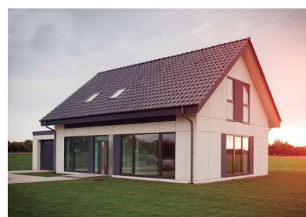
Passivhus i Tychowo nära Stargard Szczecinski i Polen. Aquarea
