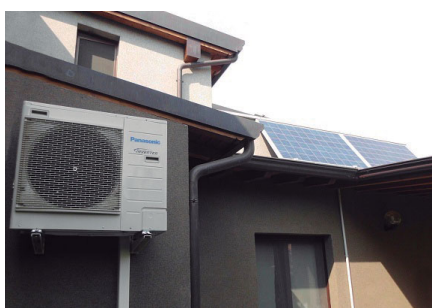
Ett hem med Aquarea solcellspaneler, tank och HPM i Lombardiet i Italien. Aquarea
