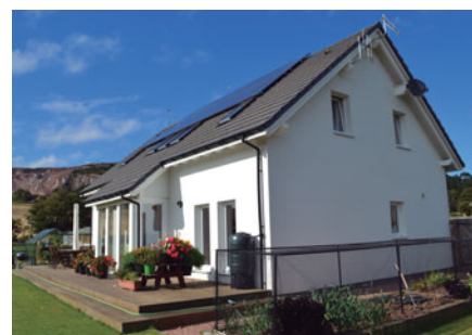
Nästan 25 000 hushåll började dra nytta av förnybara energilösningar med hjälp av Aquarea 12 kW monoblocksystem. Skottland. Aquarea
